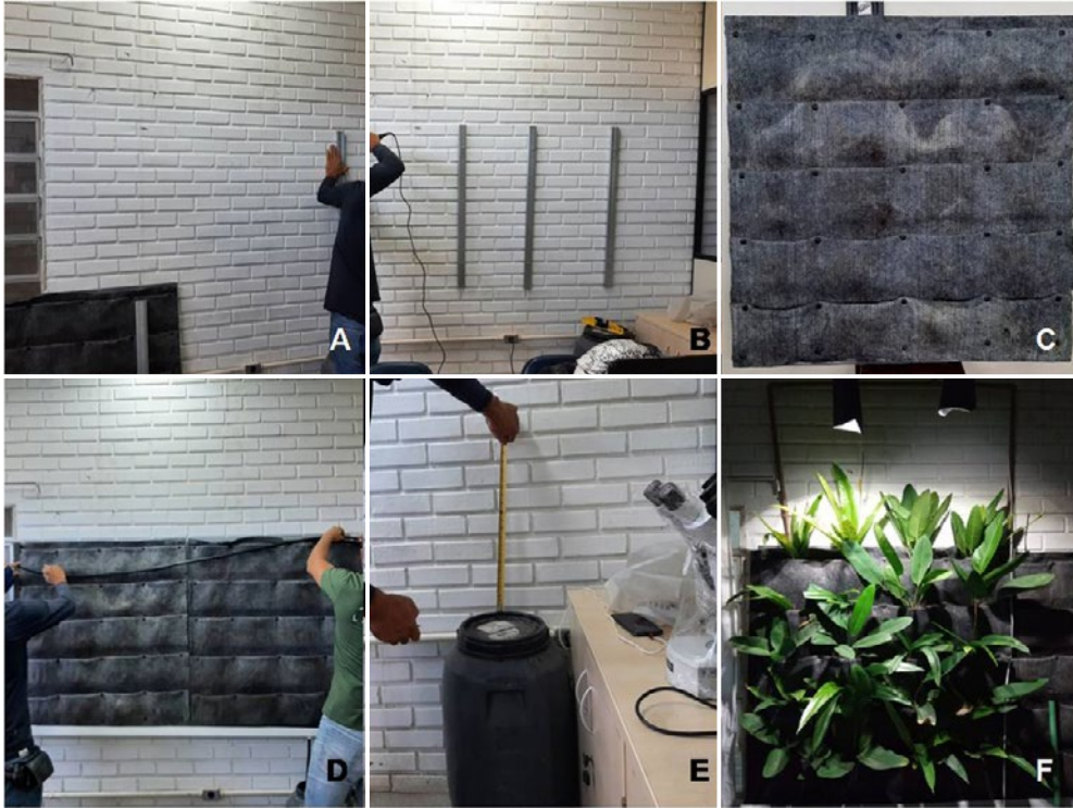
Figura 2. Montagem do painel em uma parede interna do Laboratório de Floricultura da Universidade Federal Rural de Pernambuco. A – Área para instalação; B – Instalação dos trilhos para fixação do painel; C - Painel (1m x 1m) com 20 bolsos da empresa LaPlanta®; D – Montagem do sistema de irrigação automatizada; E – Instalação do tambor para armazenamento de água; F - Efeito da iluminação artificial do painel a noite.
