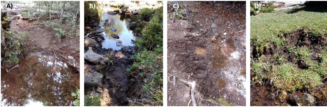
Figura 4.3: Bajadas de vaca. A y B) Cruce de un arroyo; C) Pisoteo e impacto en la orilla del cauce. D) Desmoronamiento producto del pisoteo.
