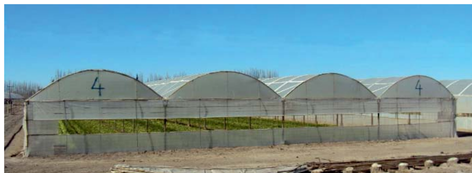
Figura 3. Invernadero multiparábólico de 24 metros de ancho.
