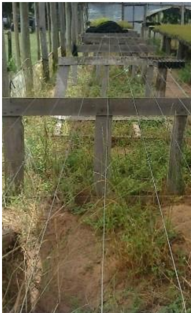
Ilustración 10: Mesadas de postes y alambres.
