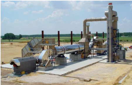
/// Figura 16. Vista general del proceso de construcción de una planta de deshidratado y recompactado, donde se aprecia el el tromel de secado (centro) y el quemador (izquierda). Foto: gentileza Apisa S. L., España.
