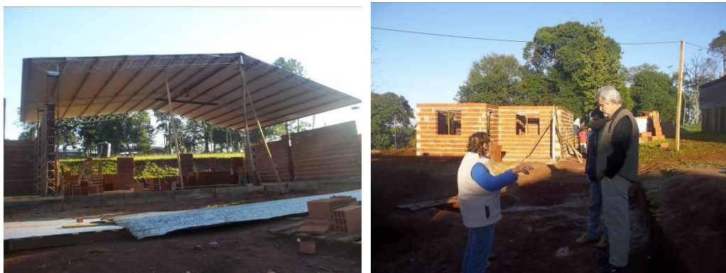
Avanza la construcción
