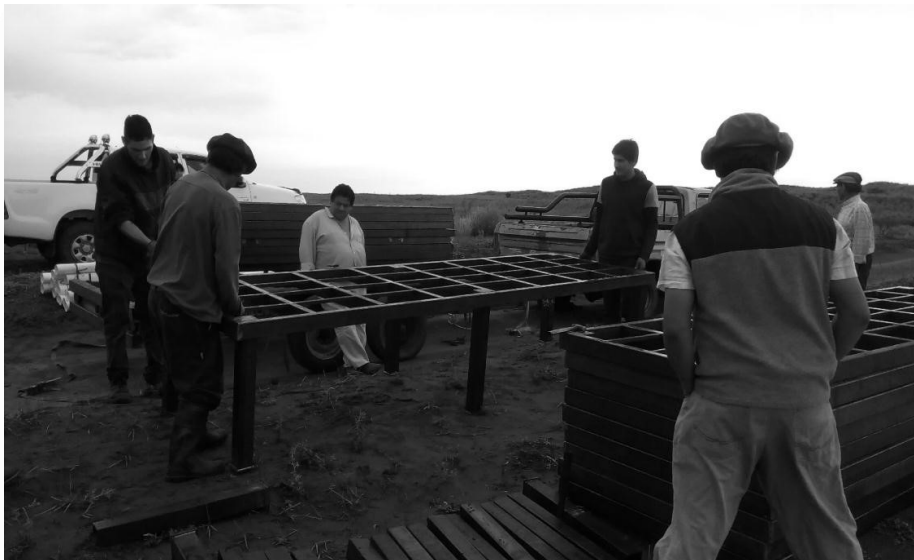
Figura 2: Bases metálicas para la colocación de tanques.
