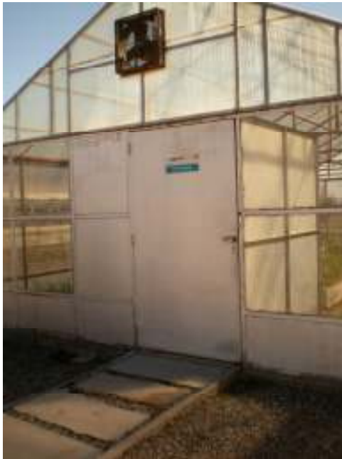
Figura 8 – Vista externa del gabinete sanitario
