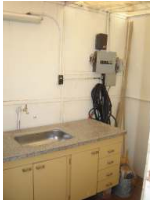
Figura 9 – Vista interna de mesada y pileta
