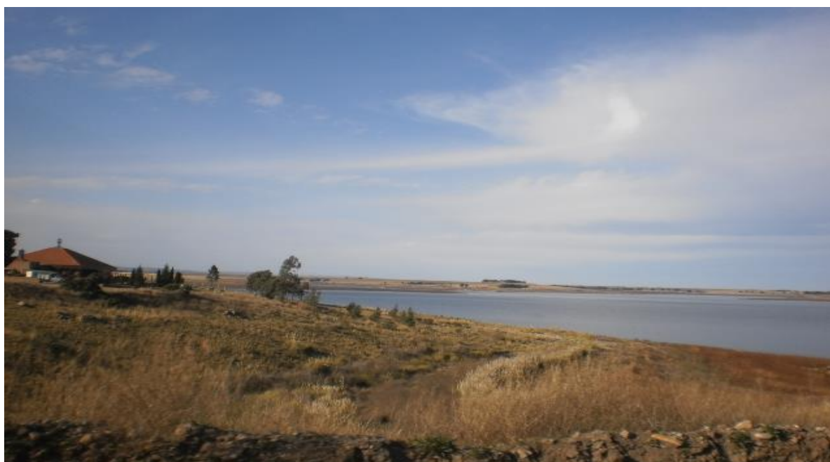
Foto 15. Embalse de “Paso de las Piedras” sobre el río Sauce Grande, toma de agua para el abastecimiento de la región.
