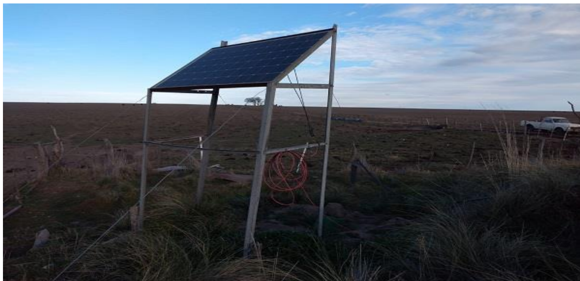
Foto 22. Utilización de pantallas solares para alimentar líneas de alambrados eléctricos y proceso básicos de mecanización rural.
