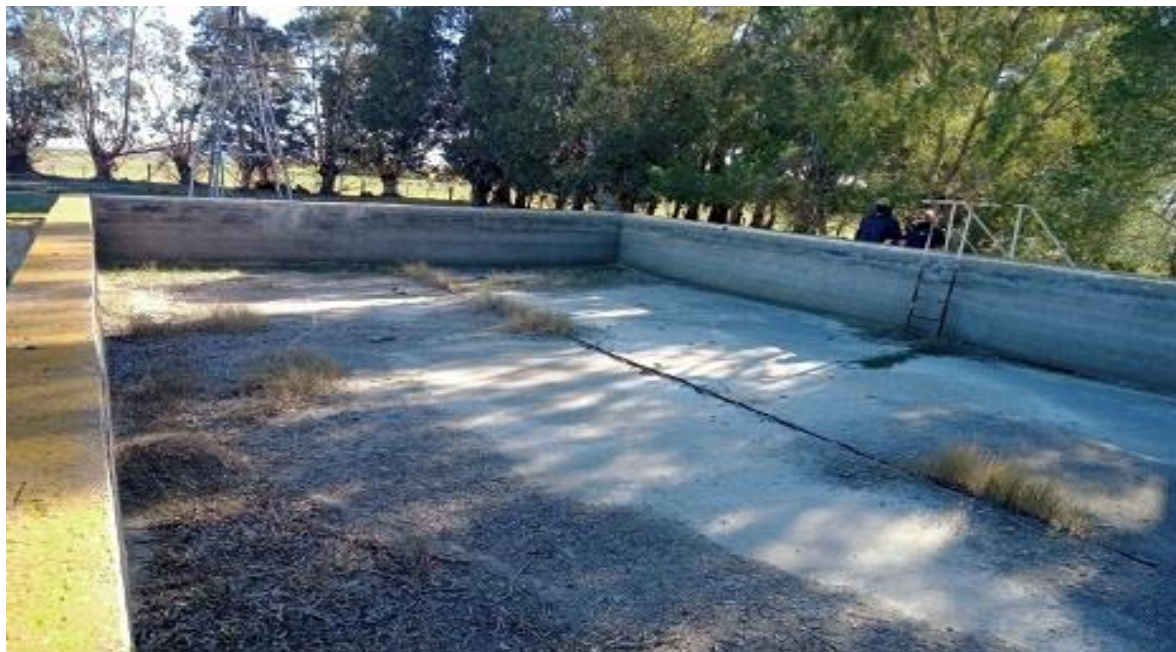
Foto 23. Infraestructura de pileta construida por los primeros habitantes de un establecimiento rural para sobrellevar veranos muy secos y de temperaturas extremas en la ruralidad del sudoeste bonaerense semiárido. Esta construcción es emulada en muchos establecimientos utilizando los tanques australianos, tajamares y lagunas naturales.
