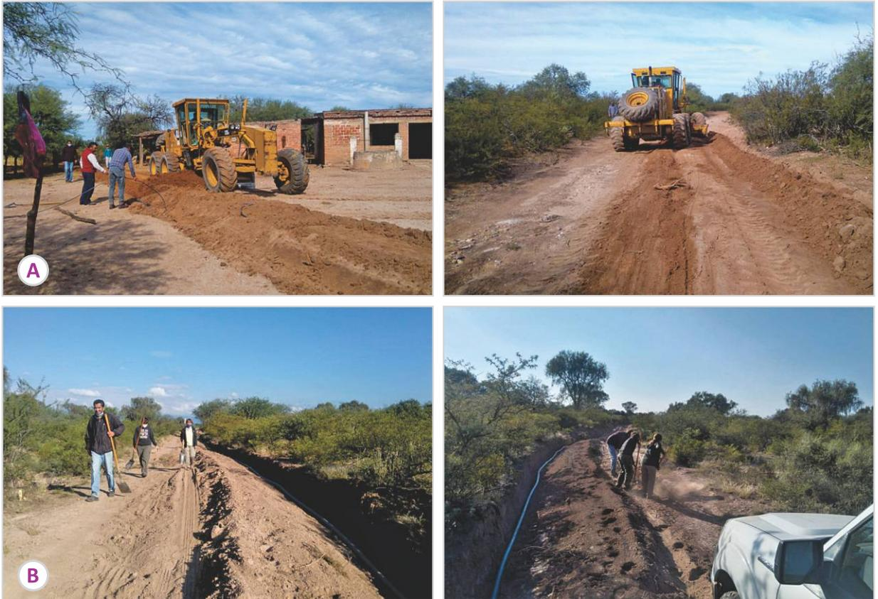
**Figura 2.** (A) Movimiento de suelo. (B) Distribución de tubería subramal Loma Alta.
