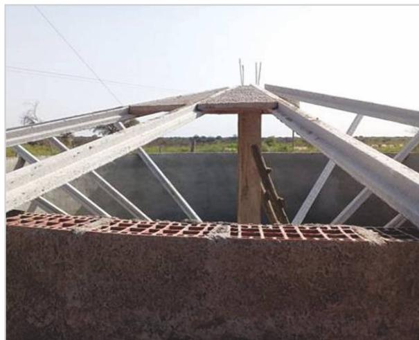
Figura 1. Detalles de construcción reservorio de 40 m<sup>3</sup> para distribución de agua rural Loma Alta.
