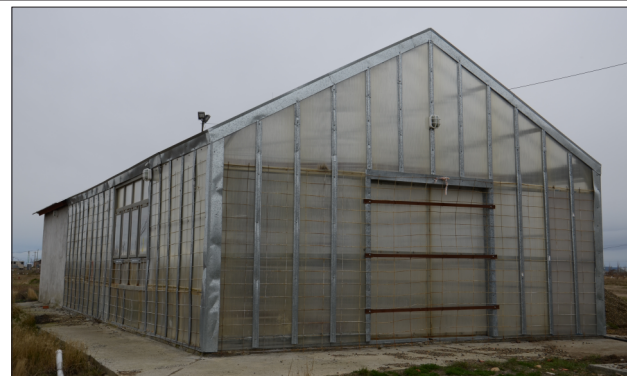
Invernadero hidropónico UNPA UARG
