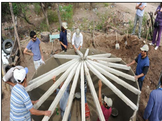
Construcción de cisterna de placa
