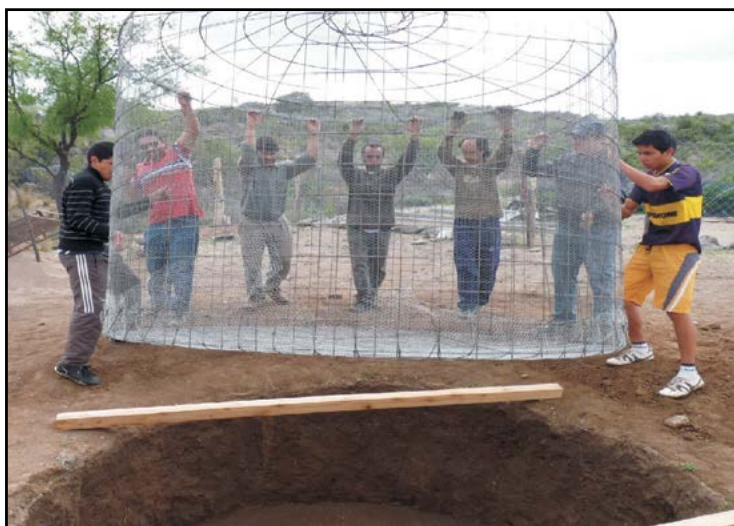
Construcción de cisterna de ferro-cemento
