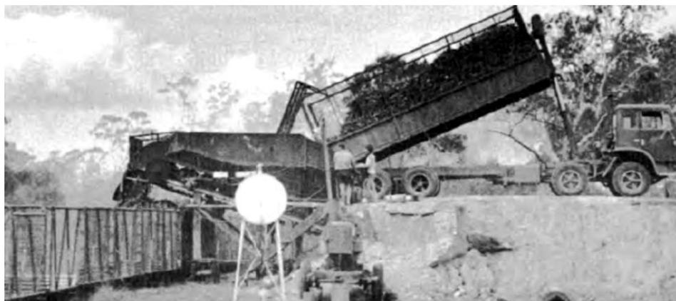
Figura 15. Semirremolque hidráulico en la operación de carga a un trasbordador. Australia, 1976 (Griggs, 2010).
