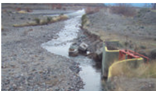
• (4) Limpieza de canales
