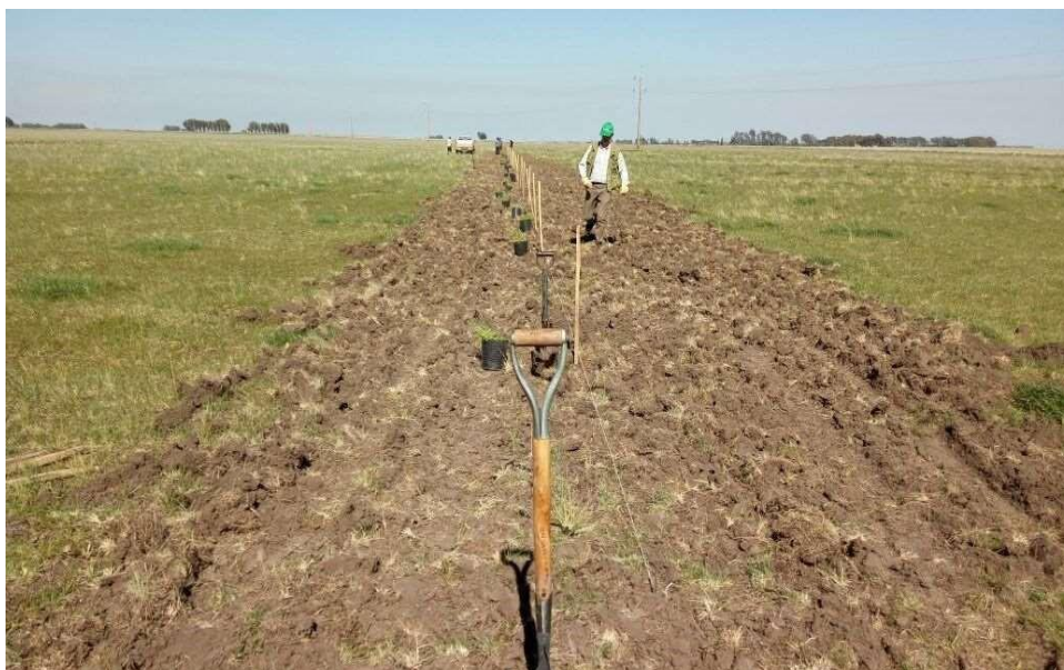
Foto 4. Medición, estaqueado y realización de pozo.
