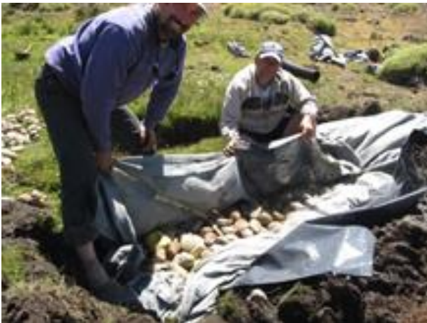
Foto 6. Recubrimiento con piedras del lugar del caño ranurado previo a terminar de envolverlo con la malla de geotextil.
