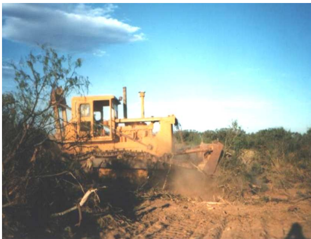
Desmote mecánico utilizando topadoras
