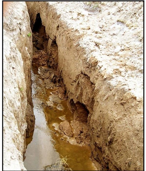
**Figura 11.** Dren con talud vertical inestable.
