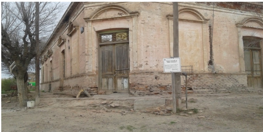
Figura 6. Fachada actual típica de las viviendas de Guardia Mitre
