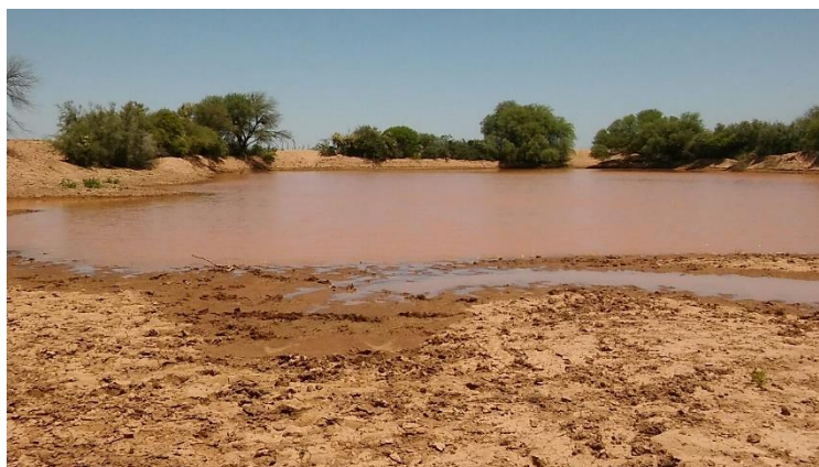
Figura 2: Represa-1 Campo "MayJu" Barrearles del Sur, presencia de vegetación escasa, bordos débilmente definidos, al no poseer estructuras de conservación presenta un alto grado de embanque.
