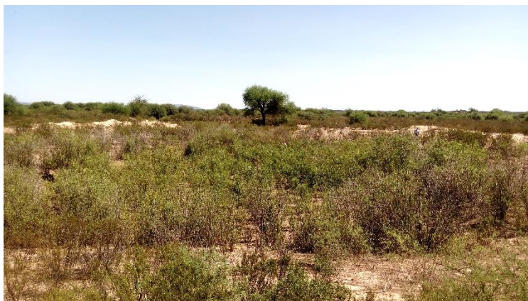
Figura 1: Detalles Represa Campo "El Español" Localidad de Usno, con alto porcentaje de vegetación en su interior, bordos débilmente definidos sin estructuras de conservación.
