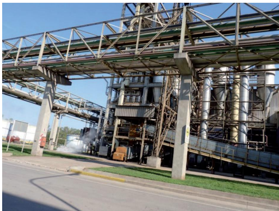
Figura 5 Planta de grandes dimensiones de biodiesel ubicada a lo largo de la hidrovía Parana Pcia de Santa Fe.
