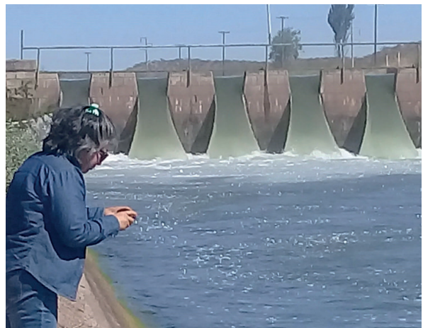
Figura 3. Muestreo de algas sobre las paredes revestidas del canal.
