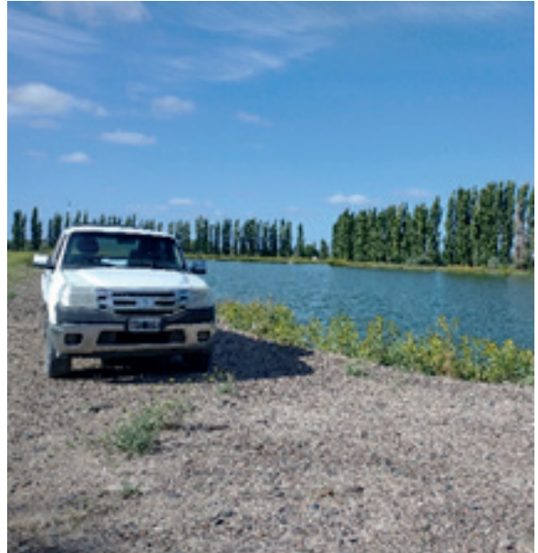
Figura 4. Pileta facultativa de tratamiento de efluentes cloacales.
