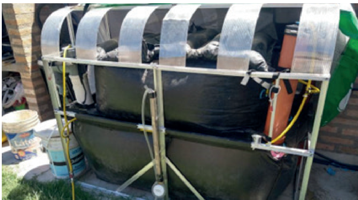
Figura 2. Detalle del biorreactor Homebiogas de 0.6 m 3 .
