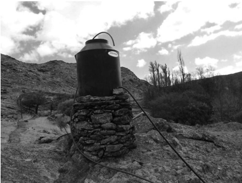
Figura 3. Tanque de almacenamiento de agua
