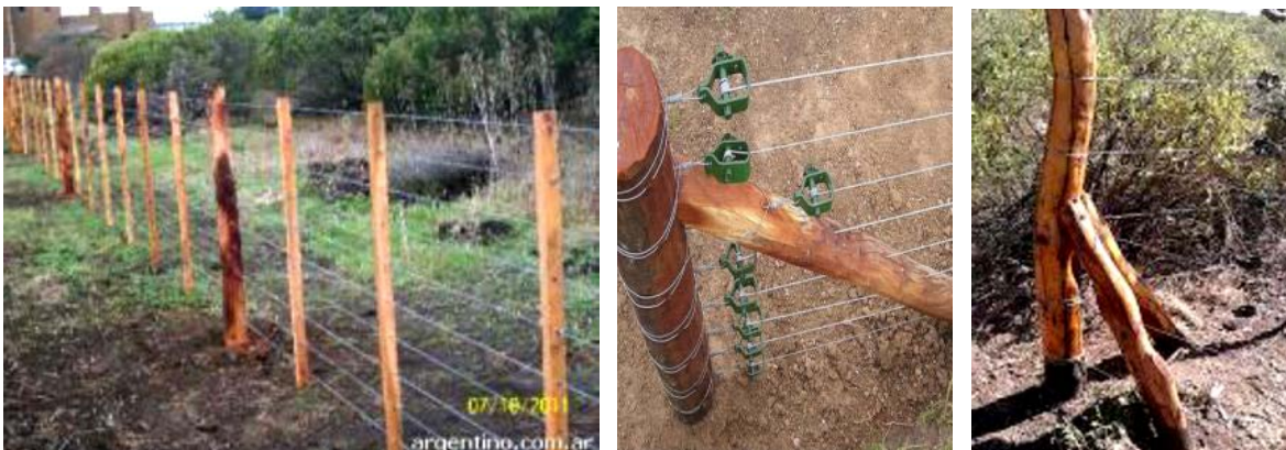
Figura 6 - Alabrado perimetral de 10 hilos, esquinero con torniquetas y esquinero de 2 muertos
