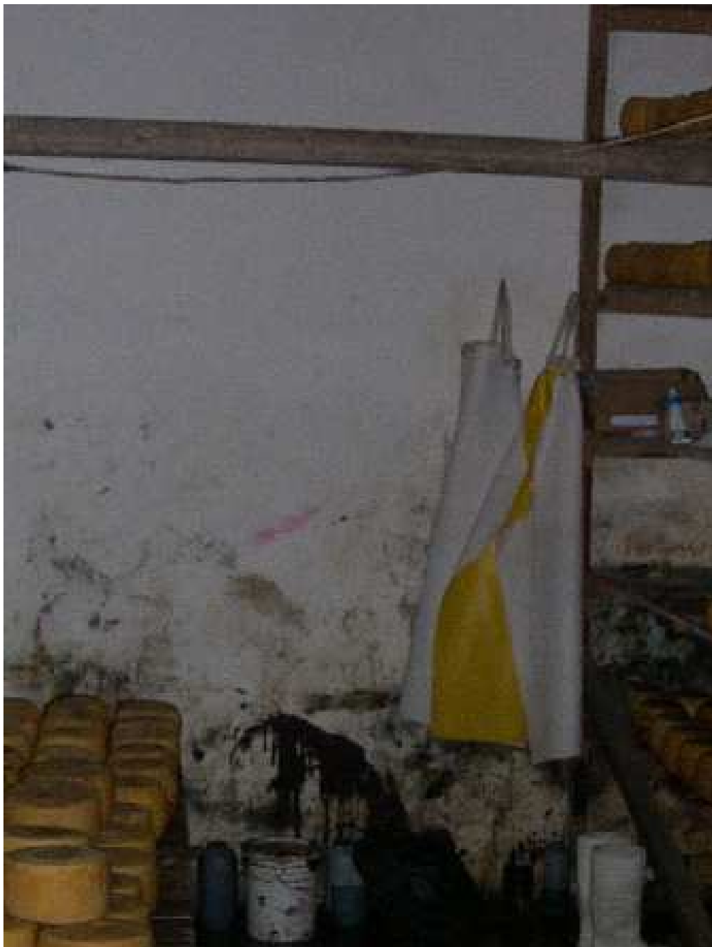
Figura N° 17: Vista de la zona de almacenamiento de productos terminados.
