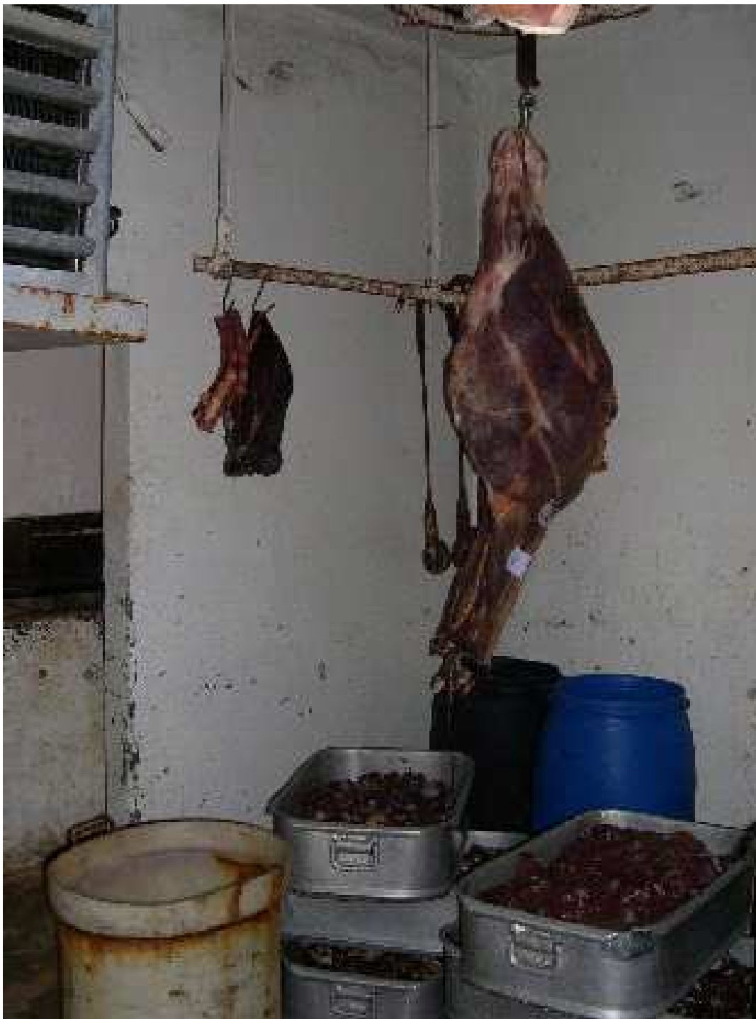
Figura N° 18: Vista del interior de una cámara frigorífica.
