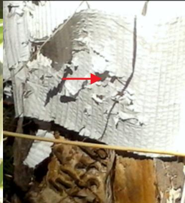
FIG. 10. Faja deteriorada luego de una lluvia intensa.
